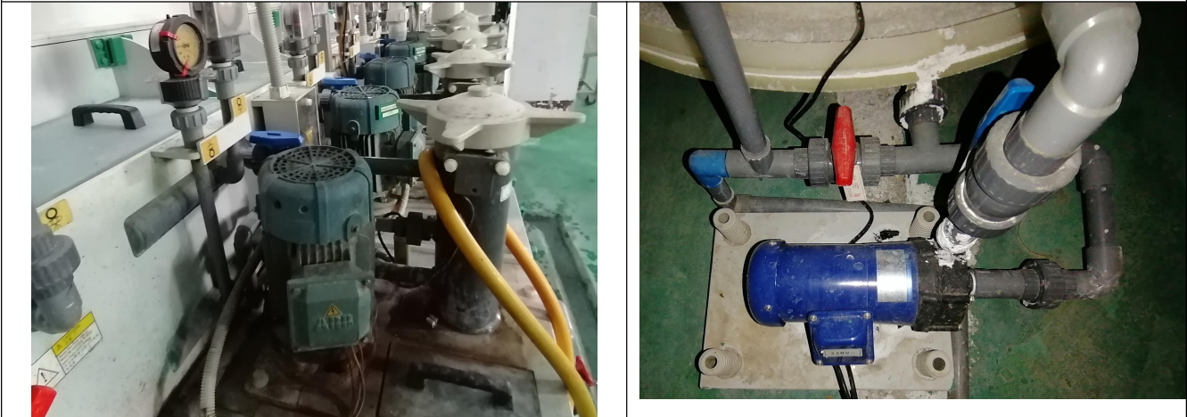
废水泵（位于污水处理站内）
