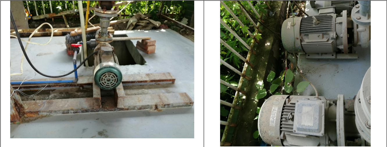
废水泵（位于污水处理站内）
