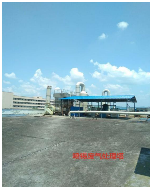
一厂喷锡废气排气筒
