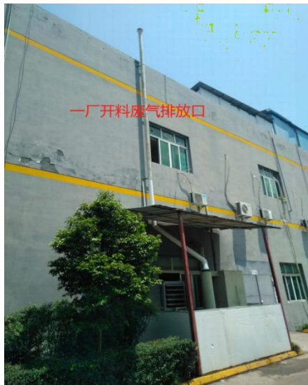
开料工序除尘器+15m 排气筒
